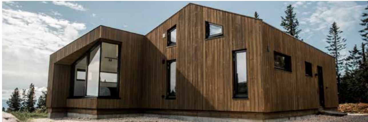
GENERELT Hytta leveres fra topp ringmur.
