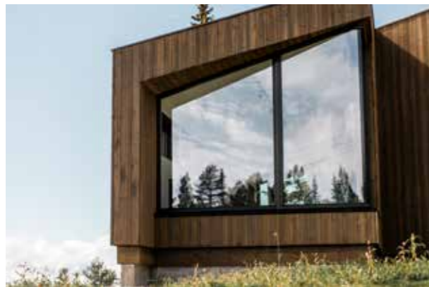
VINDUER Vinduer og balkongdører i malt utførelse. NCS S8000N. U-verdi i.h.h.t TEK 10. Foringer leveres i samme farge som vinduer.
